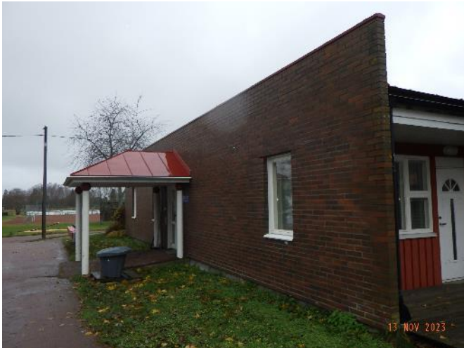
Bild 19. Tegelfasaden mot väster.
