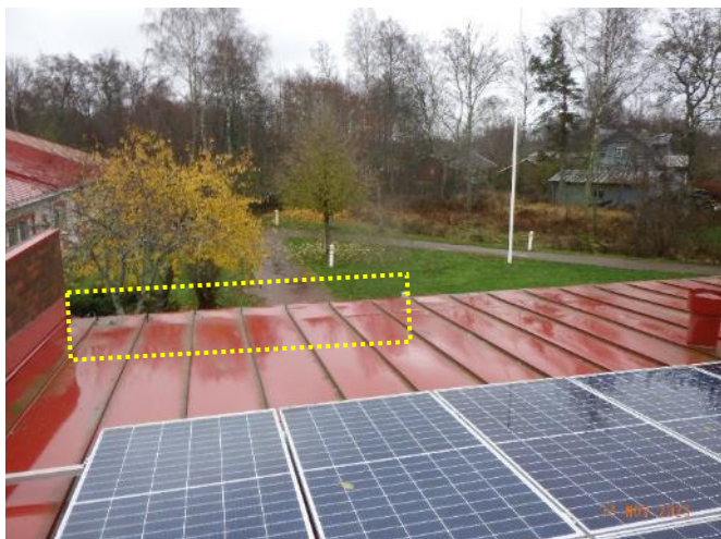
Bild 3. Område var plåten observerades vara böjd uppåt vid takkanten.
