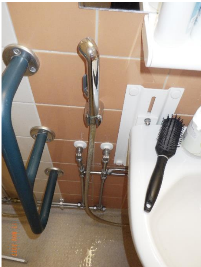
Bild 37. Bidéhanddusch i lägenhet 7 läcker.
