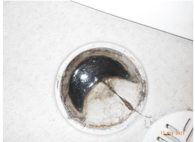
Bild 34. Golvbrunnar av plast med förhöjningsring i badrummen.
