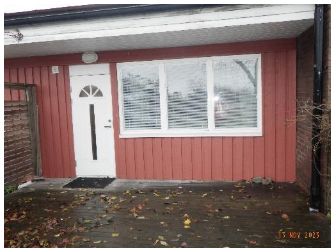
Bild 24. Fasaden mot söder.
