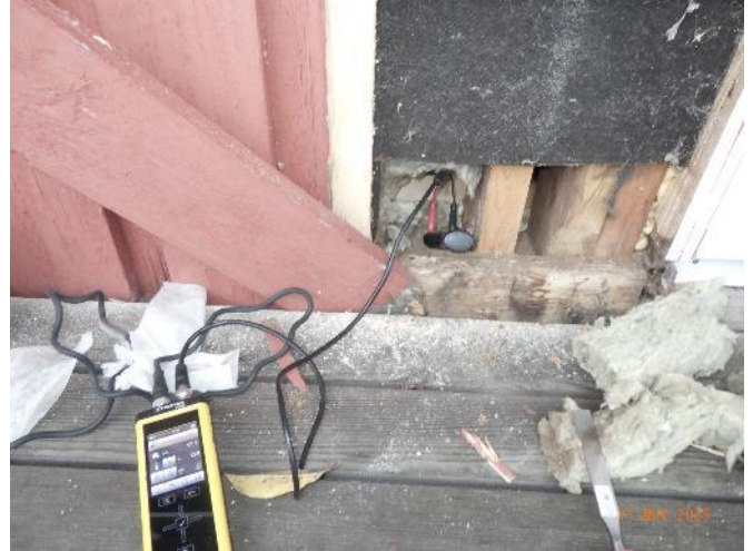
Bild 28. Fuktkvoten mättes i syllen. Ingen förhöjd fuktkvot konstaterades.
