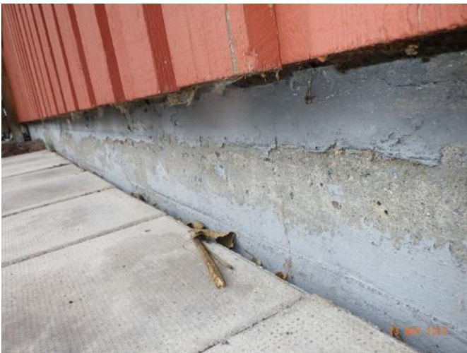
Bild 17. Färgen har börjat släppa på merparten av sockeln.
