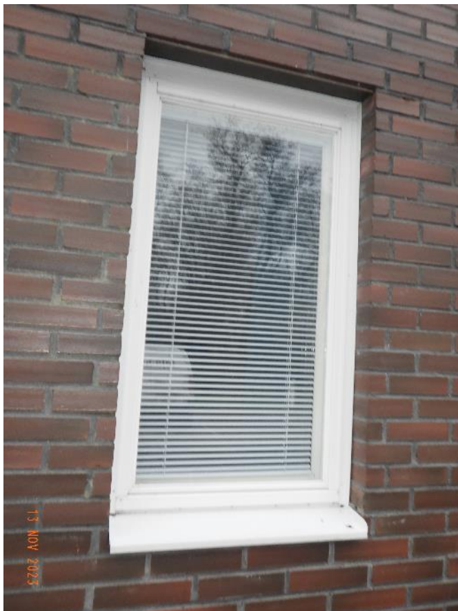
Bild 30. Fönster vid tegelfasaden.
