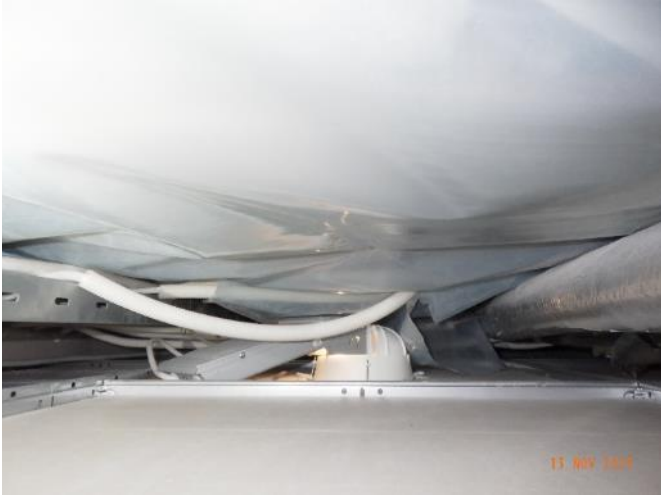
Bild 11. Genomföringar konstaterades vara otäta genom ångspärr.
