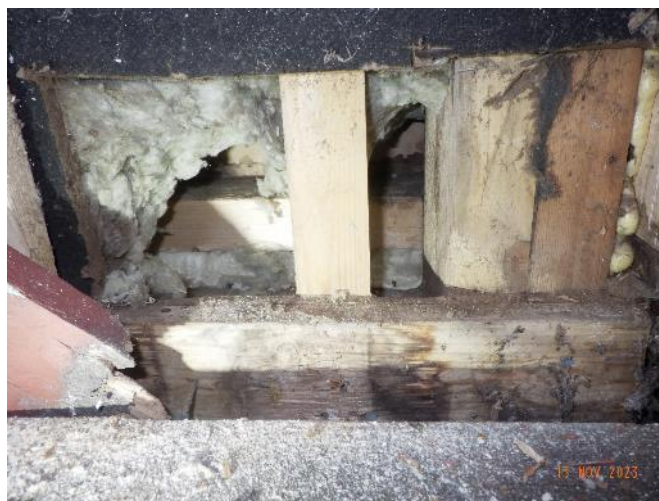
Bild 26. Kontrollhålet som öppnades utifrån in i ytterväggen. Kontrollhålet öppnades utanför lägenhet 6 i vägg mot söder.
