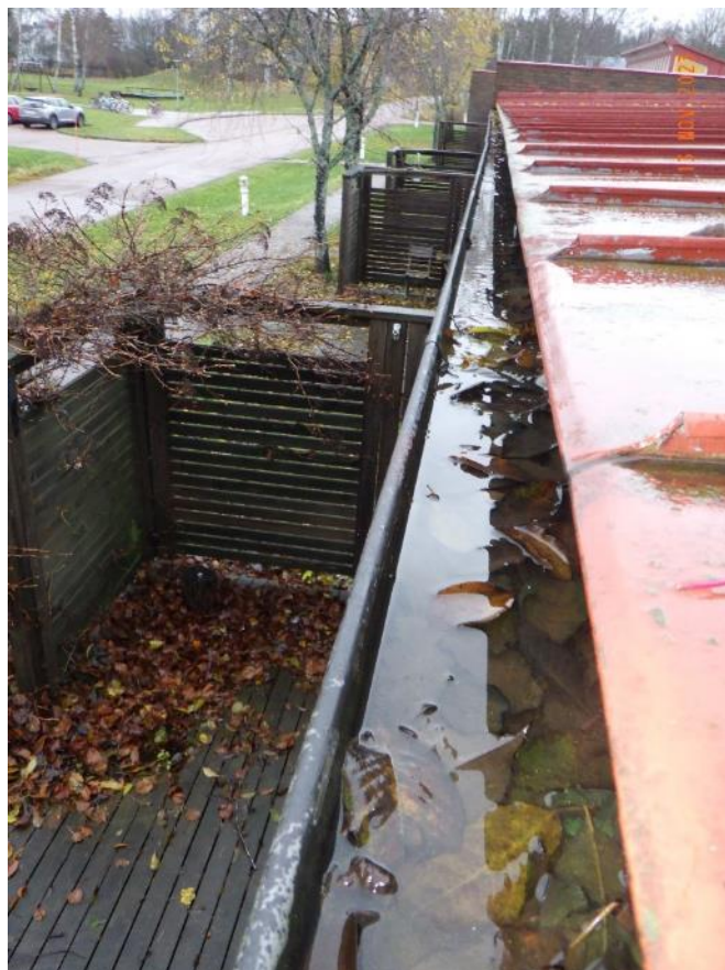
Bild 8. Hängrännor löv- och vattenfyllda.
