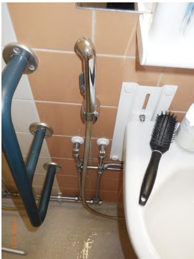
Bild 37. Bidéhanddusch i lägenhet 7 läcker.
