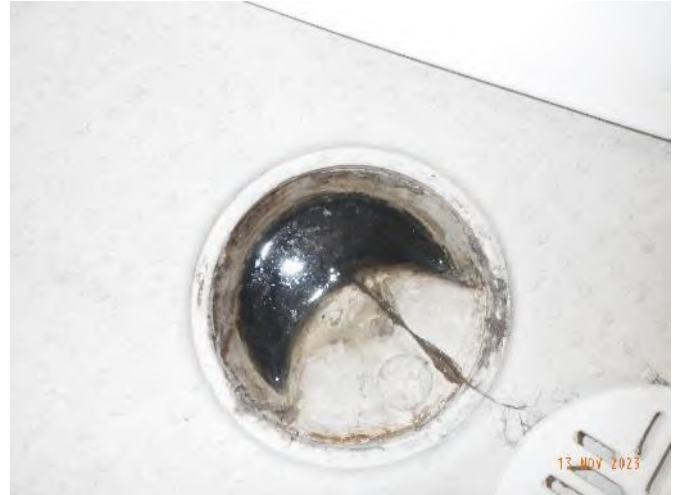
Bild 34. Golvbrunnar av plast med förhöjningsring i badrummen.
