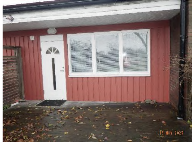
Bild 24. Fasaden mot söder.
