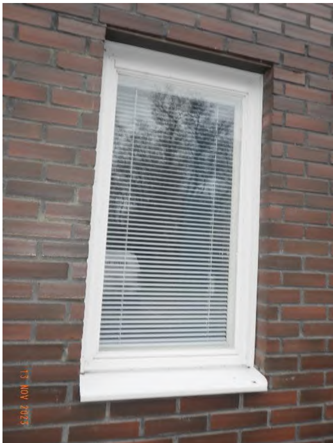
Bild 30. Fönster vid tegelfasaden.
