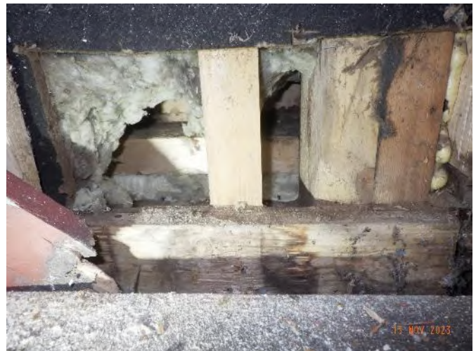
Bild 26. Kontrollhålet som öppnades utifrån in i ytterväggen. Kontrollhålet öppnades utanför lägenhet 6 i vägg mot söder.
