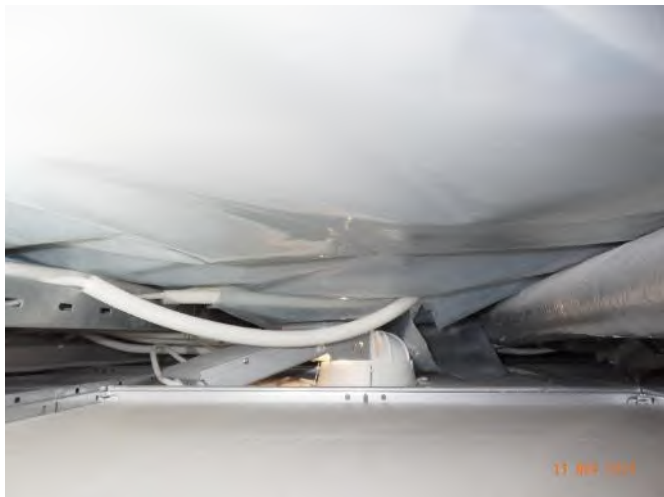
Bild 11. Genomföringar konstaterades vara otäta genom ångspärr.
