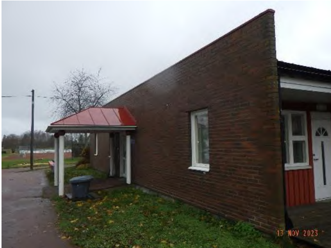
Bild 19. Tegelfasaden mot väster.
