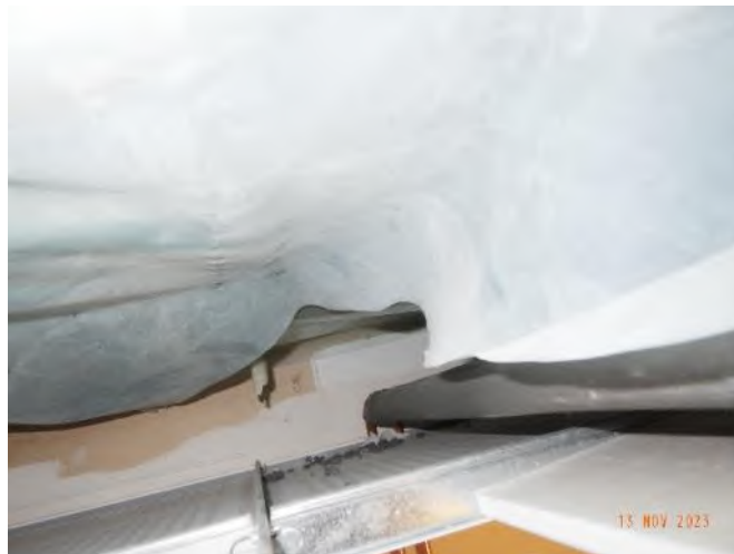
Bild 12. Överlapp av i plasten konstaterades ej har tejpats med för ändamålet menat tejp, ångspärren otät.
