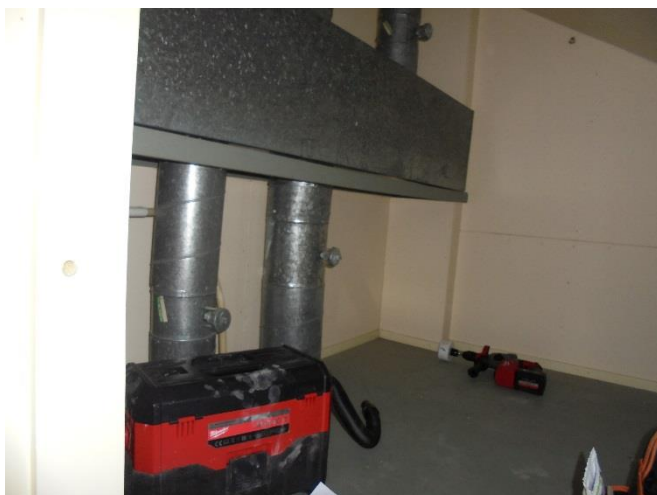
Bild 1. Kontrollhål för granskning av bjälklag öppnades i teknikrum på övre våningen.
