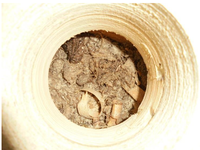
Bild 10. Golvtyp2. Kontrollhålet öppnades i arbetsrum mot den västra ytterväggen.
