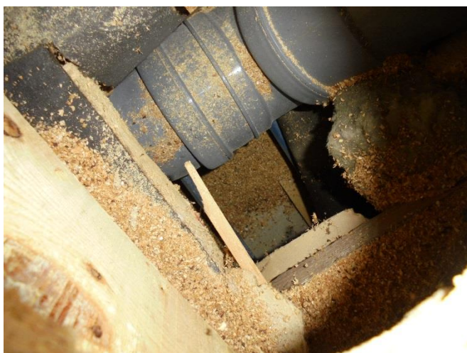
Bild 2. Spånisolering finns i bjälklaget.
