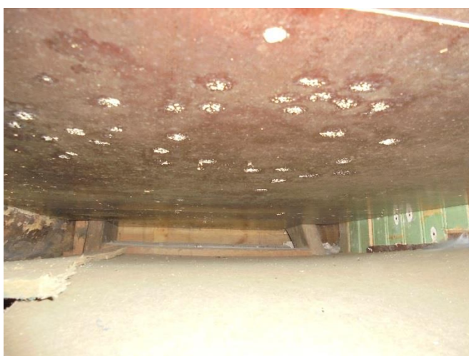
Bild 17. På skivornas undersida observerades något som kan vara mikropåväxt. Påväxten har högst sannolikt orsakats av att kondensdroppar bildats på skivans glatta undersida och damm eller andra orenheter har gett näring åt påväxten
