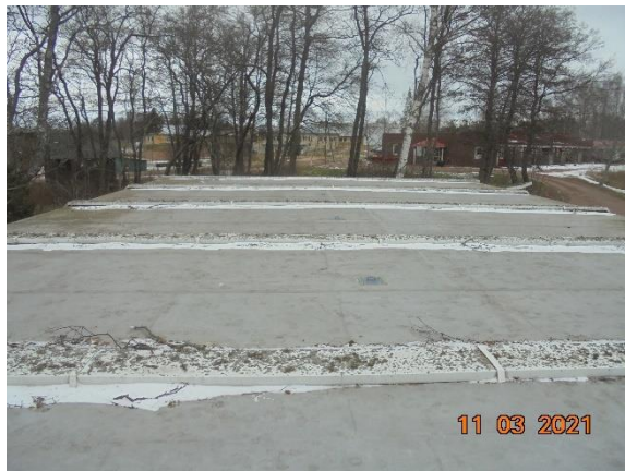
Bild 3. Snö och löv samlas mot skarvplåtar.
