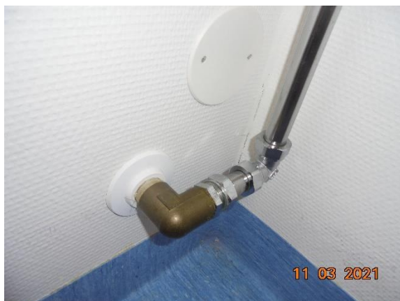
Bild 23. På väggytor gjordes fuktkartläggning med yfuktindikator, inga avvikelser kring vattenrör noterades.
