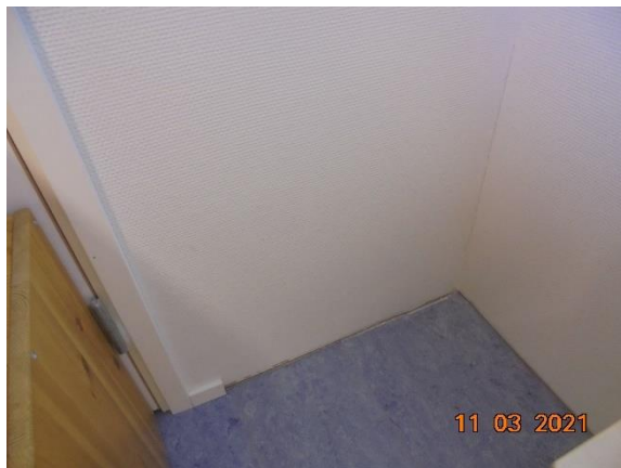
Bild 34. I allrummets korridor saknas fotlister delvis mot gavel utan förbindelsegång.
