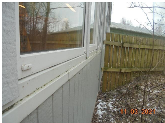
Bild 13. Fönstren monterade i ytterkant vägg ansluter mot skarvbleck i fasaden.
