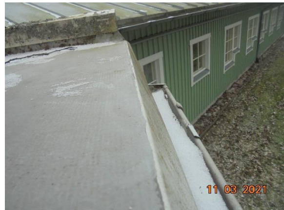
Bild 4. I takkant övergår PVC till kantplåt.
