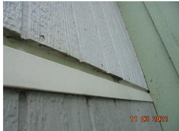
Bild 10. Fasadfälten skarvade och skarven försädda med plåtbleck.
