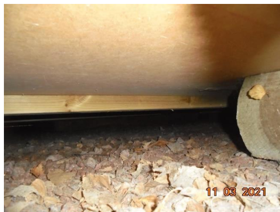
Bild 8. Underredet granskades från område där sockelbeklädning öppnades.
