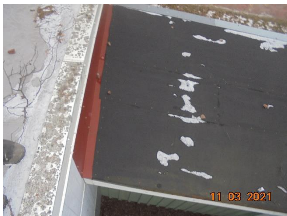
Bild 5. Förbindelsegången har ett filttak.
