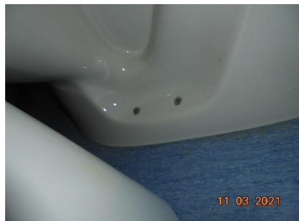
Bild 24. Man noterar att wc-stolar är skruvade varpå tätheten av limningen är kritisk för golvet täthet.
