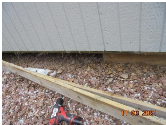
Bild 7. Byggnaden står på en grusbädd och träbalkar av impregnerat virke.
