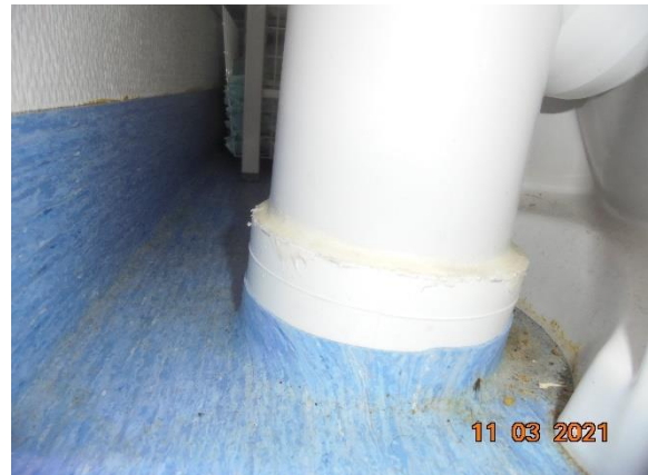
Bild 15. Genomföringar i golv granskades okulärt, inget att anmärka på. Plastmatta sakenligt uppvikt på rör.
