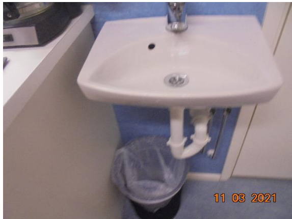
Bild 28. Lilla handfatet, då man spolar kranen med maximalt flöde skvätter vatten över kanten på golv.
