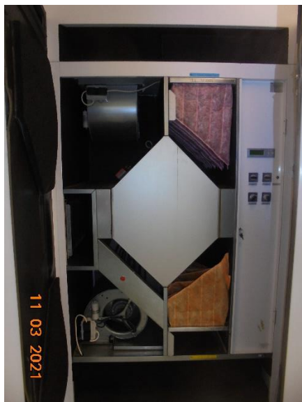
Bild 39. Ventilationsaggregatet öppnades och granskades okulärt invändigt. Aggregatet rent vid granskningstillfället.
