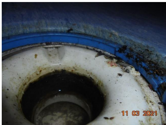
Bild 21. Plastmattans anslutning till golvbrunn ser tät och sakenligt monterad ut.
