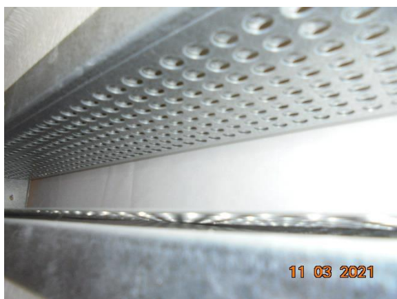
Bild 41. Ett antal utrymmen har överluftsdon med ljuddämpning.
