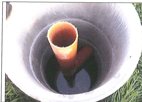
Bild 5: Nivåbrunn med insatsrör (nivårör) som ännu saknar handtag. Gummipackningen i böjen på brunnsbotten har plockats bort för enkel insättning och uttag av nivåroret.
